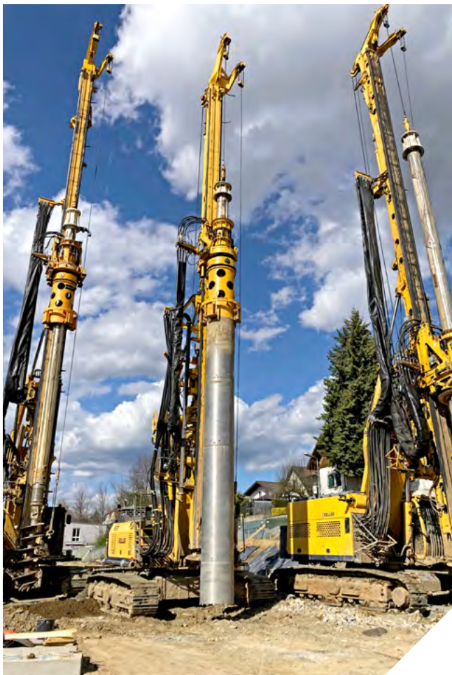
HERSTELLUNG DER CA. 700 PFÄHLE in nur zehn Wochen mit zum Teil drei Bohrpfahlgeräten
