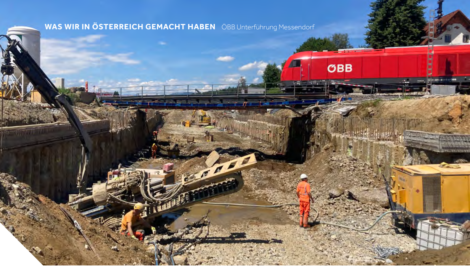
HERSTELLUNG DER TEMPORÄRANKER
