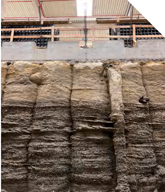
FREIGELEGTE SOILCRETEWAND
