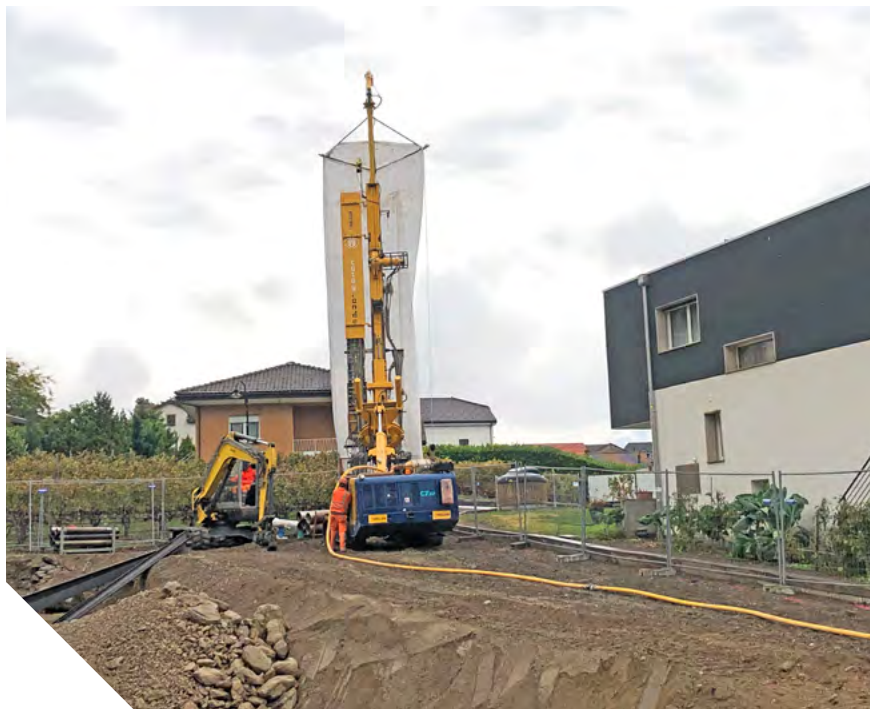
VERTIKALBOHRUNGEN - TRÄGERBOHLWAND
