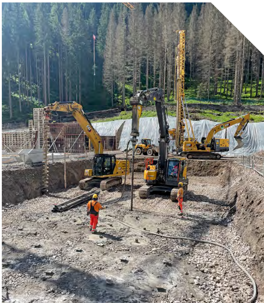
EINBAU VON RAMMPFÄHLEN
